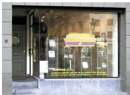
Un accès recréé en retrait de la façade
