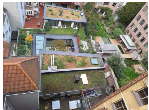
Intérieur d'îlot depuis la toiture des Bains de Bruxelles - rue du Chevreuil 28 - Octobre 2020 © ERU & AAC
