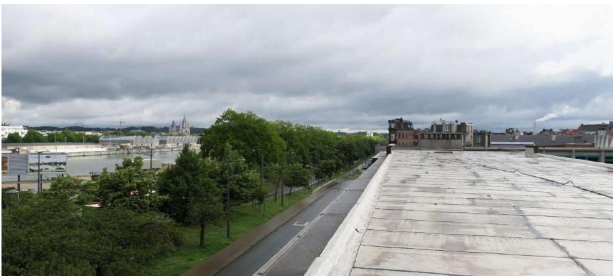
Toiture vers Canal, Ecole Klavertje Vier - allée Verte, 16 - Juillet 2020 © ERU & AAC
