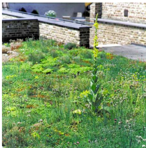
Toiture verte et contribution à la biodiversité, l'idée n'est pas neuve et pourtant très actuelle Source: Info fiche Eco-construction, Bruxelles Environnement 2009
