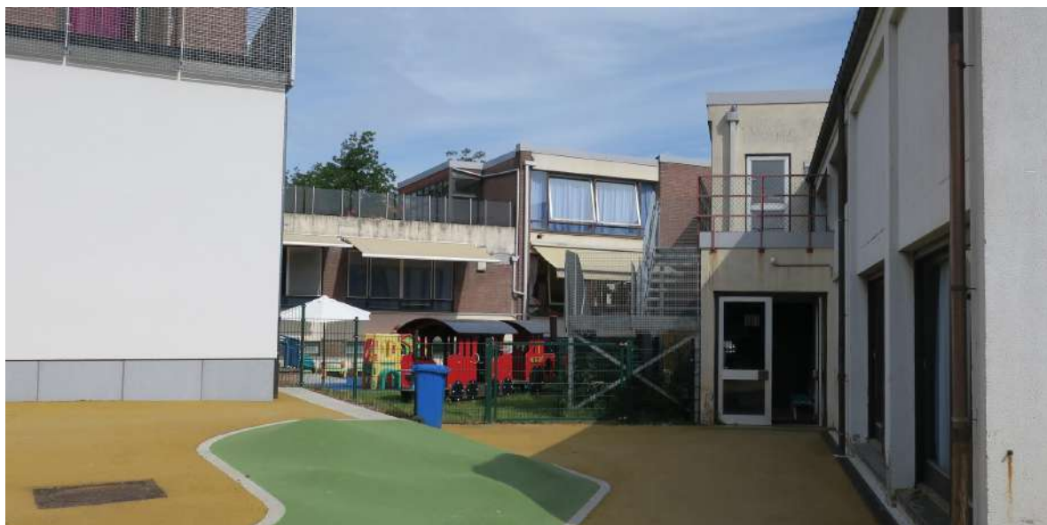
Toitures depuis la cour de récréation - Ecole Laneau, rue Leopold I, 116 - Juin 2020 © ERU & AAC
